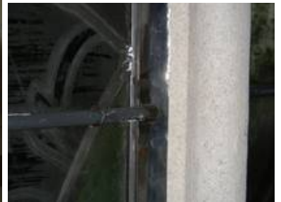
Das Windeisen ist mit Laschen, kraftschlüssig, auf dem Messingrahmen befestigt.
