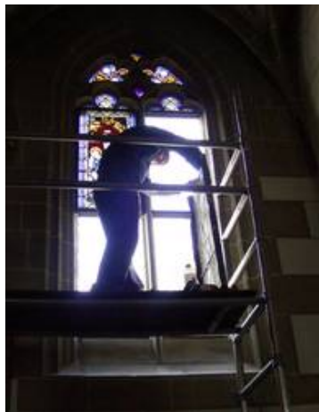
Prüfender Blick auf die Aussenschutzverglasung vor der Montage der restaurierten mittelalterlichen Glasmalereien.
