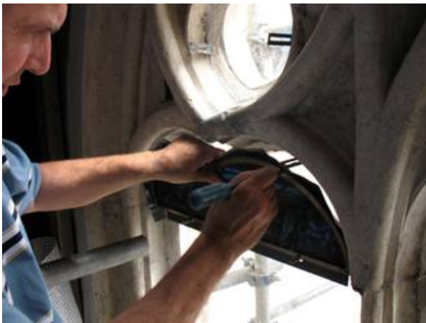
Einsetzen einer Kopfscheibe in die Haltekonstruktion.
