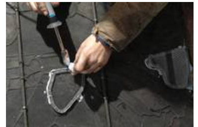
Abdecken von losen Malschichtschollen
