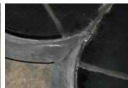
Das verlötete Messing-U-Profil an einer anderen Felderform
