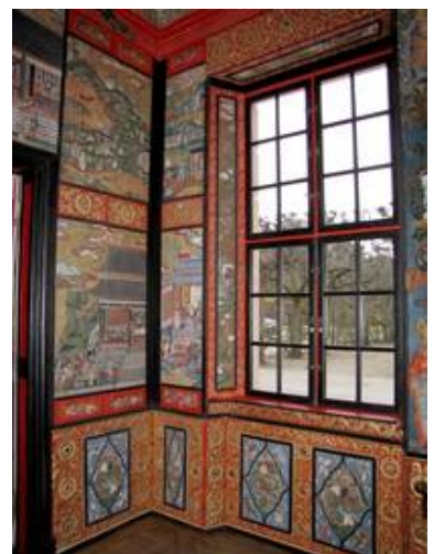
Ermitage in Bayreuth UV-Schutzverglasung in Holzfenstern.
