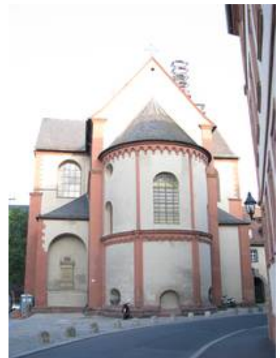
Eine völlig unauffällige Art des UV-Schutzes - vollintegriert in eine Bleiverglasung mit klassischen mundgeblasenen Antikgläsern
