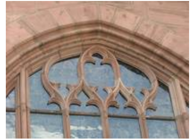
Durch den einschleibigen Aufbau sind auch komplizierte Scheibenformen wie im Maßwerk möglich.
