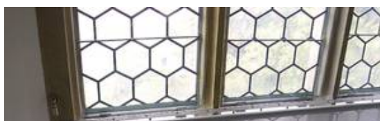
Ermitage in Bayreuth UV-Schutzverglasung in Holzfenstern.
