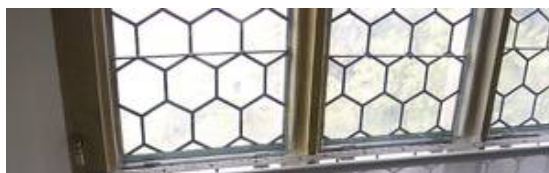
Ermitage in Bayreuth UV-Schutzverglasung in Holzfenstern.
