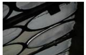
Etliche der Rundscheiben drohten aus dem Bleinetz zu fallen
