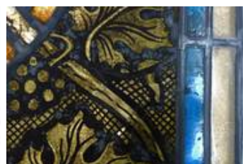
kopistische Ergänzung nIV1a IS-DL Fehlstelle 1 Nachzustand
