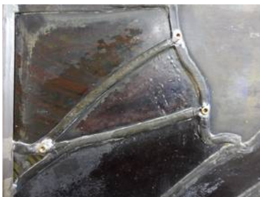
Die zu korrigierende Scheibe mit den aufgelöteten Muttern
