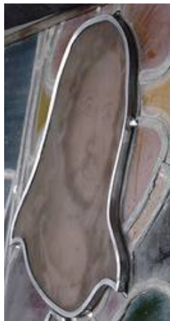
Auf der Rückseite des Feldes reversibel aufgesetzte Doublierung.
