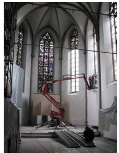
Der Ausbau der Originalverglasung erfolgte mittels einer Hubarbeitsbühne
