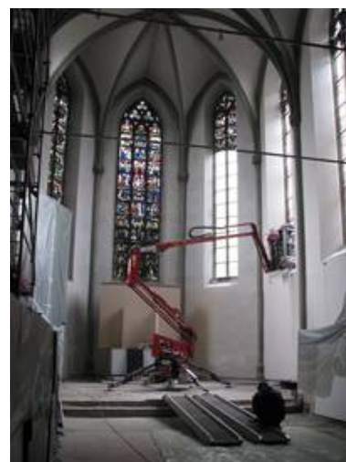
Der Ausbau der Originalverglasung erfolgte mittels einer Hubarbeitsbühne
