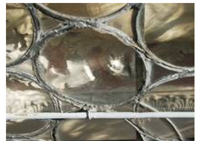
Der Vorzustand des Bleinetzes zeigt das leider nicht alle Bleie gehalten werden konnten, schließlich sollte die Dichtigkeit der Gebäudehülle wieder hergestellt werden
