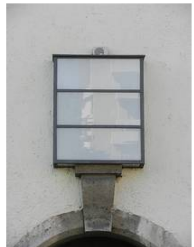
In dieser Ansicht ist die bewegte Oberfläche des maschinengezogenen Milchüberfangglases gut zu erkennen
