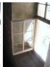
Nachzustand der Holzfenster, partiell mussten verwitterte Hölzer getauscht werden.
