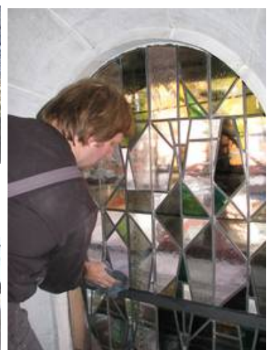
Nachreinigung der Bleiverglasungen in situ.
