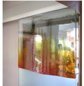
Detail der automatischen Glasschiebetür mit aufgeklebtem, mundgeblasenen echt-Antik-Überfangglas in nahezu originaler Größe ca. 900 x 640 mm und Sandstrahlung als Sichtschutz im unteren Bereich
