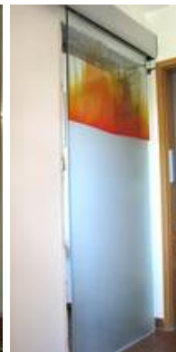
Automatische Glasschiebetür mit aufgeklebter, mundgeblasener echt-Antik-Überfangglasscheibe
