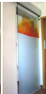
Automatische Glasschiebetür mit aufgeklebter, mundgeblasener Echt-Antik-Überfangglasscheibe
