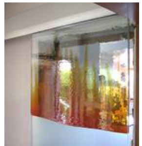
Detail der automatischen Glasschiebetür mit aufgeklebtem, mundgeblasenen Echt-Antik-Überfangglas in nahezu originaler Größe ca. 900 x 640 mm und Sandstrahlung als Sichtschutz im unteren Bereich
