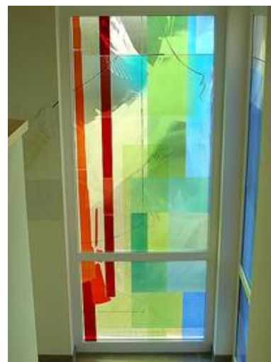
Floatglasmalerei in Kombination mit aufgeklebten mundgeblasenen Echt-Antikgläsern und Ätztechniken in der Emmaus Gemeinde in Babenhausen nach Entwürfen von Eberhard Münch
