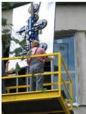
Die Montage der Scheiben erfolgte mit einem Kran
