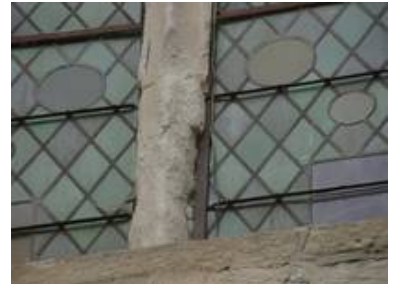
Die Steinschäden an der Schlosskapelle waren erheblich; gut zu erkennen auch die Aufteilung der Bleifelder und die ursprünglichen Orte der Glasmalereischeiben.
