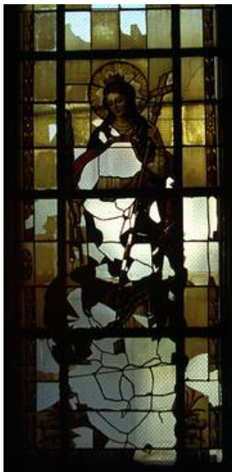
Selbst dieses stark beschädigte Bleinetz konnte bei der Restaurierung erhalten werden.
