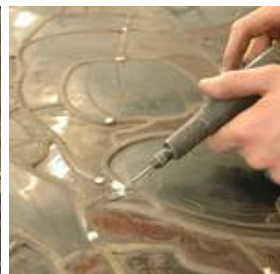
Punktuell Entfernen der Oxidationsschicht des Bleies.
