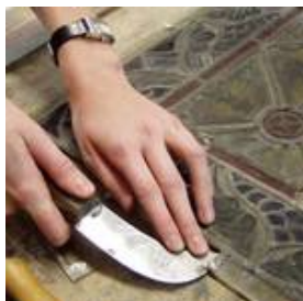
Vorsichtiges Ausrichten des Bleinetzes.
