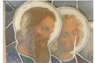
Das feingliedrige originale Bleinetz einer Glasmalerei im Vorzustand von aussen.
