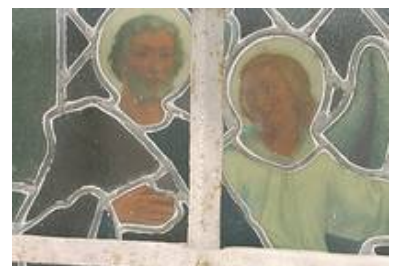
Ein anderes Fenster im gleichen Bestand wurde historisch neuverbleit. Deutlich tritt der Filigranitätsverlust hervor.
