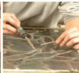
Kontrolliertes Nachlöten der Bruchstellen.
