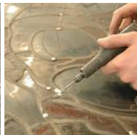
Punktuell Entfernen der Oxidationsschicht des Bleies.
