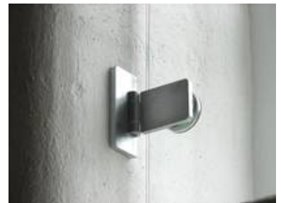
Individuell modifizierte Halter für eine besondere Kombination von Glasart und -größe
