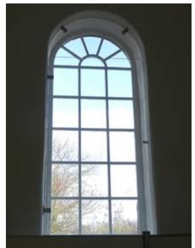
Die Hauptfenster bestanden aus einem Drehflügel und einem feststehenden Oberlicht
